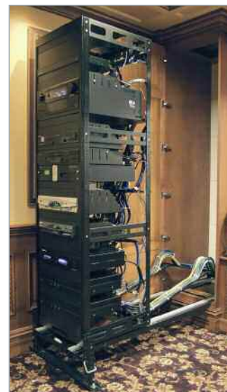
AXS geöffnet auf Service-Schienen und -Ständer
