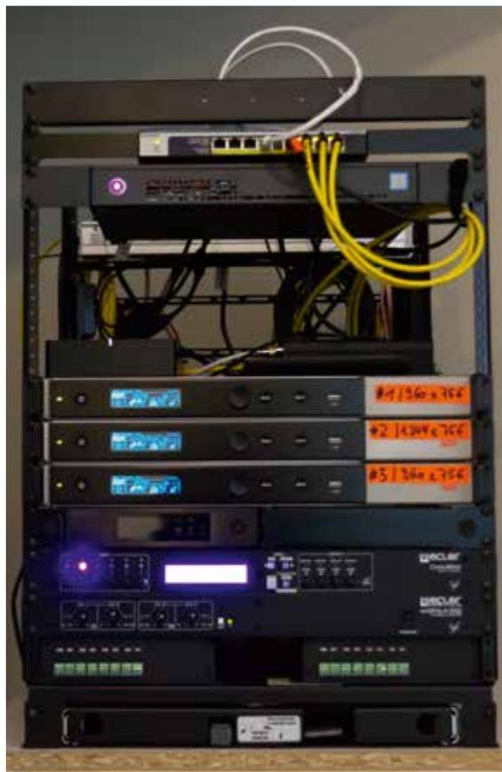
Die Bedienung der LED-Wand erfolgt über ein Interface. Jeder der drei Teilbereiche der Fläche wird über einen eigenen Controller angesteuert.
