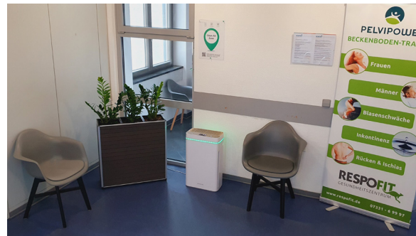
Schutz für Patienten und Mitarbeiter: RespoFit installierte 5 AiroDoctor antivirale Luftreiniger in Kursräumen, auf der Trainingsfläche und im Umkleidebereich
